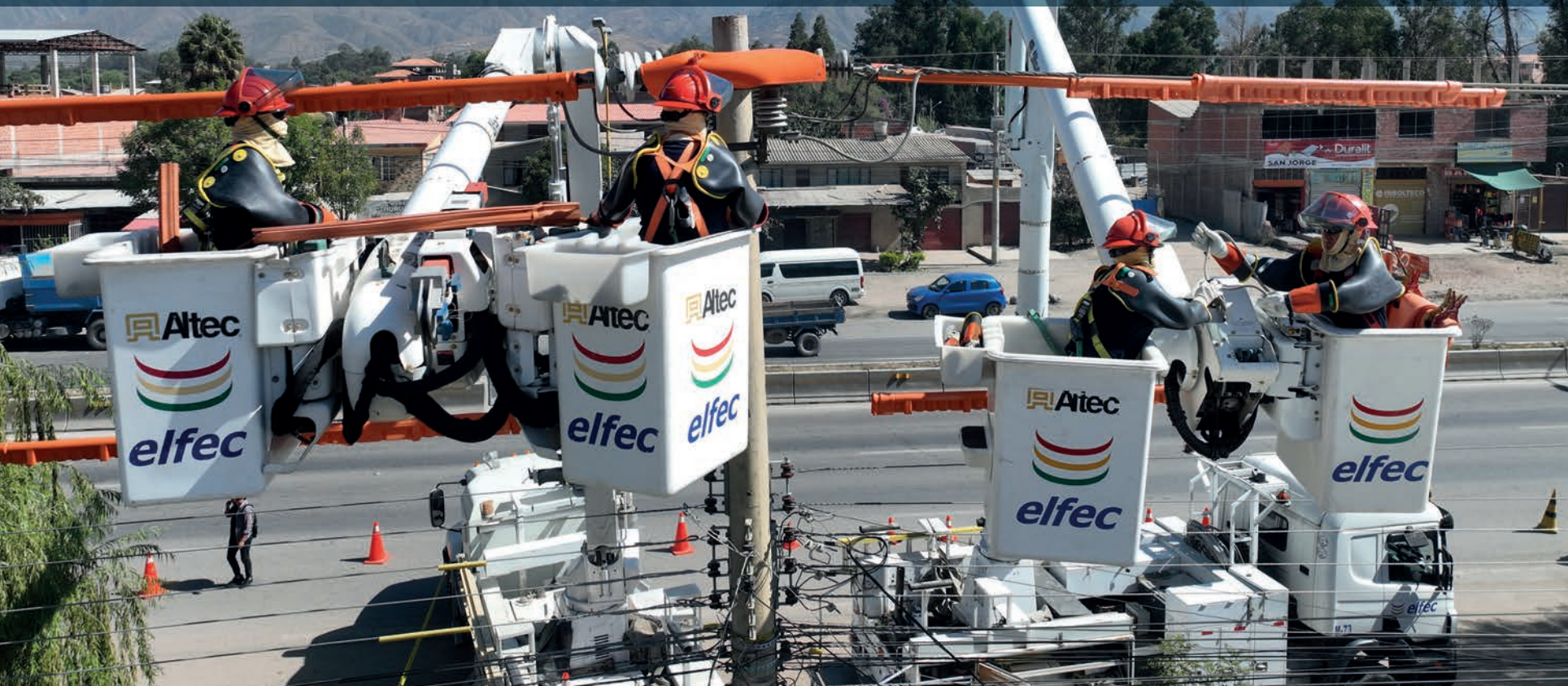
Trabajos de rectificación de línea viva, departamento de Cochabamba, municipio de Quillacollo (Foto: ENDE-ELFEC, 2023)
