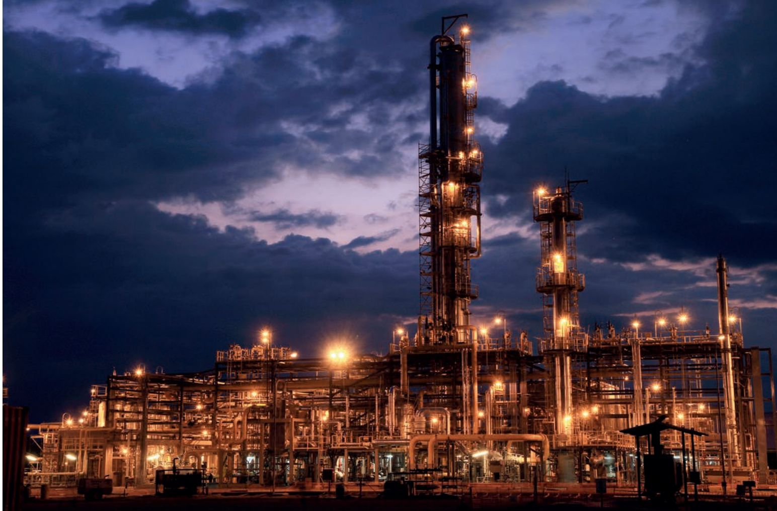
Planta Separadora de Líquidos de Río Grande, departamento de Santa Cruz (Foto: MHE-YPFB)
