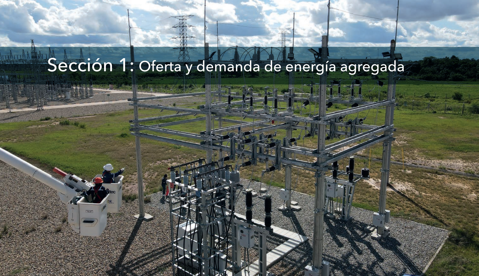
Construcción de bahía y castillo de distribución en la subestación Paraíso, departamento del Beni, municipio de Trinidad (Foto: ENDE-DELBENI, 2024)
